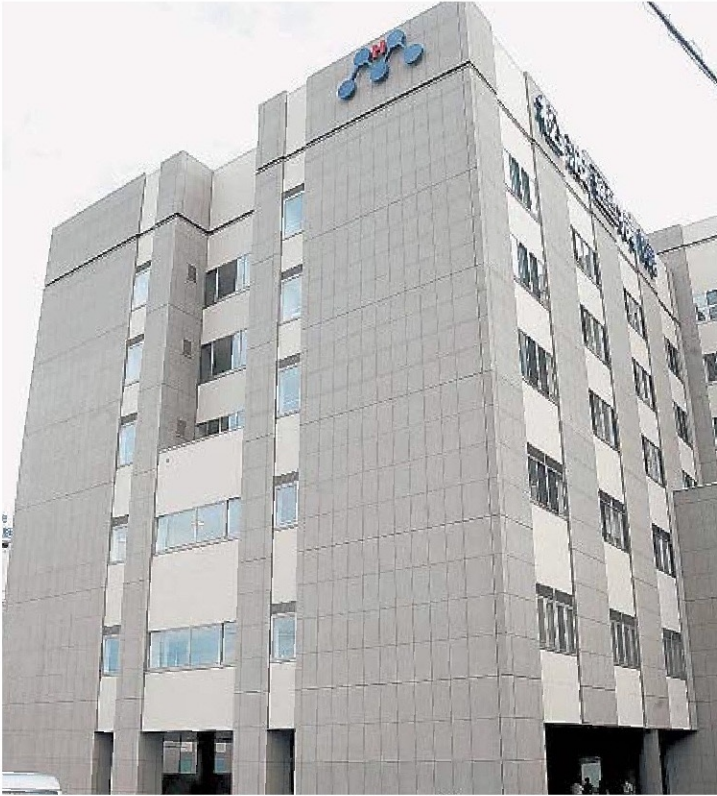
22日に開院する松波総合病院の新館「ノースウイング」＝笠松町田代
