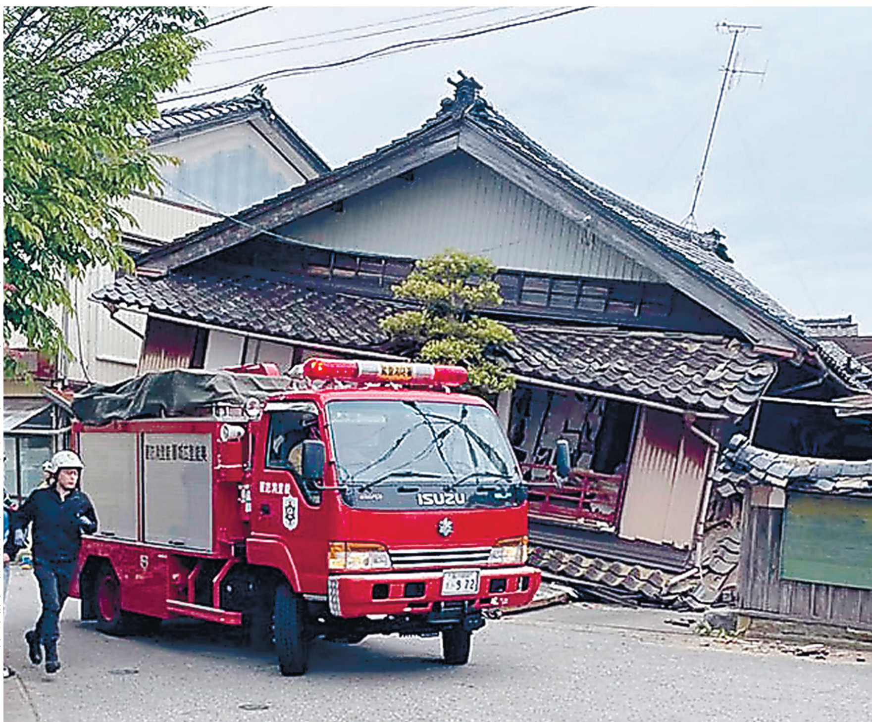
石川県珠洲市で震度6強を観測した地震で崩れた家屋。5日午後、近隣住民提供。
