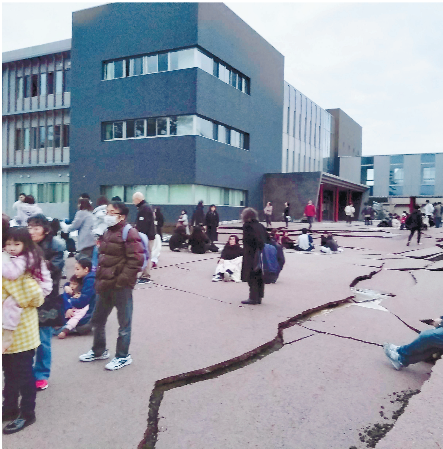
強い地震で起きたひび割れ＝1日午後4時50分ごろ、石川県輪島市
