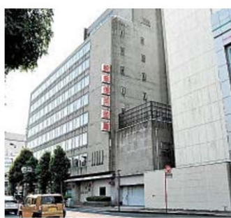
建て替えが決まった岐阜信用金庫本店ビル＝岐阜市神田町
