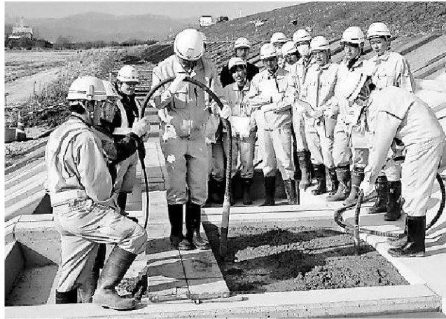
護岸工事を体験する岐阜農林高校の生徒ら＝瑞穂市呂久、揖斐川
