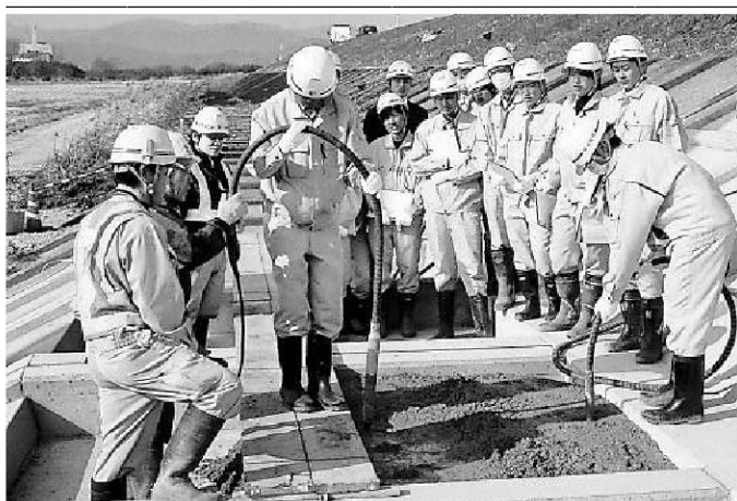
護岸工事を体験する岐阜農林高校の生徒ら＝瑞穂市呂久、揖斐川
