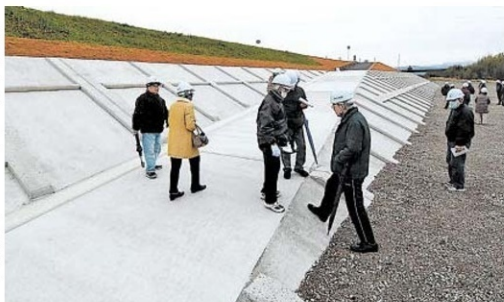
完成したコンクリート護岸を見学する住民たち＝大野町下座倉
