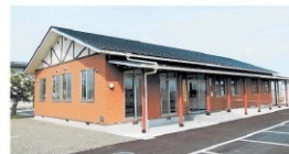
県就農支援センター事務・研修棟 ＝海津市海津町平原
